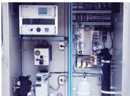
Foto 2. Sistema de Monitoramento Contínuo de Emissões (CEMS).
